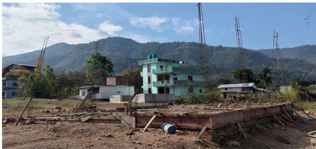
प्रहरी चौकी भवन निर्माणकसेनी, पाल्पा
