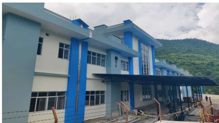
गाउँपालिकाको निर्माणधन १५ सैया अस्पताल
